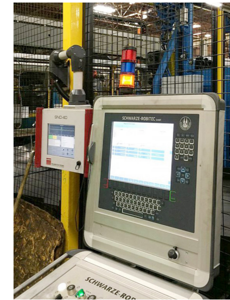
Gesteuert von der „NxG“ werden die zu bearbeitenden Rohre aus dem Magazin entnommen und der Schweißnaht-Sucheinrichtung Typ „Roland SND 40“ zugeführt.
